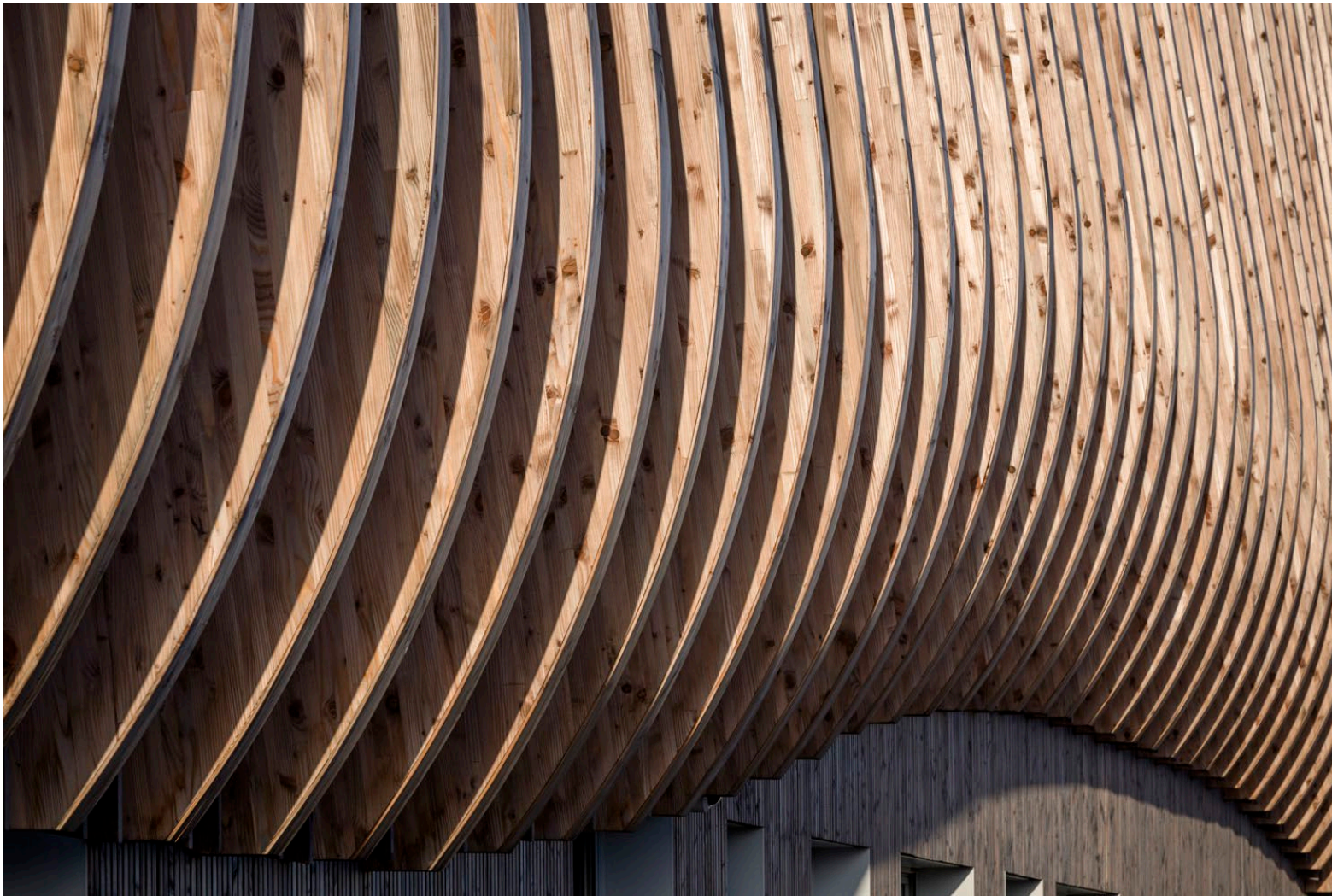
Structure en bois
